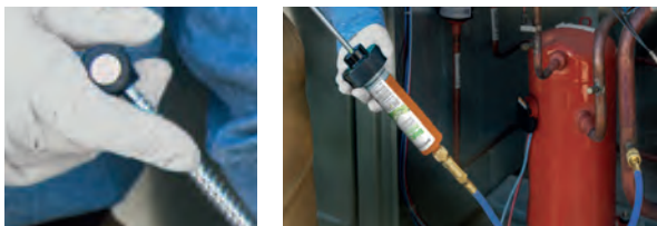
Injektion des Färbemittels durch Drehen des Griffs.
