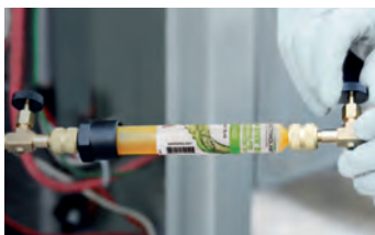
Befüllung mit dem Kältemittel
