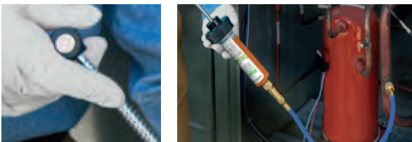
Injektion des Färbemittels durch Drehen des Griffs.
