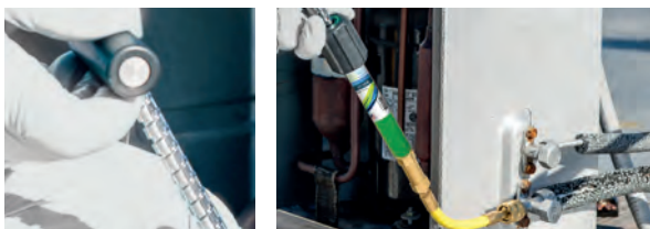
Injektion des Färbemittels durch Drehen des Griffs.
