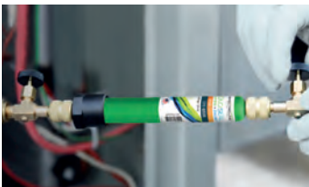
Befüllung mit dem Kältemittel
