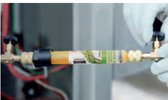
Befüllung mit dem Kältemittel
