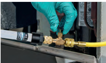
Befüllung mit dem Kältemittel
