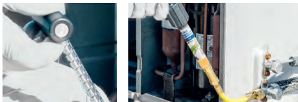
Injektion des Färbemittels durch Drehen des Griffs.
