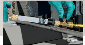
Charge en ligne avec le réfrigérant
